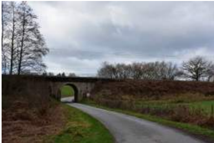
Pont ferroviaire de la ligne Paris-Toulouse.
