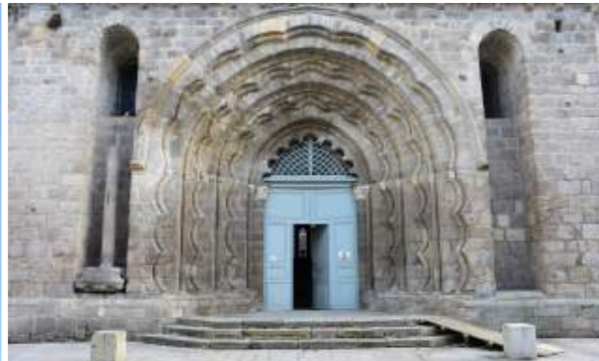
Photographie 82 : Portail principal de l'église Notre-Dame de la Souterraine.
